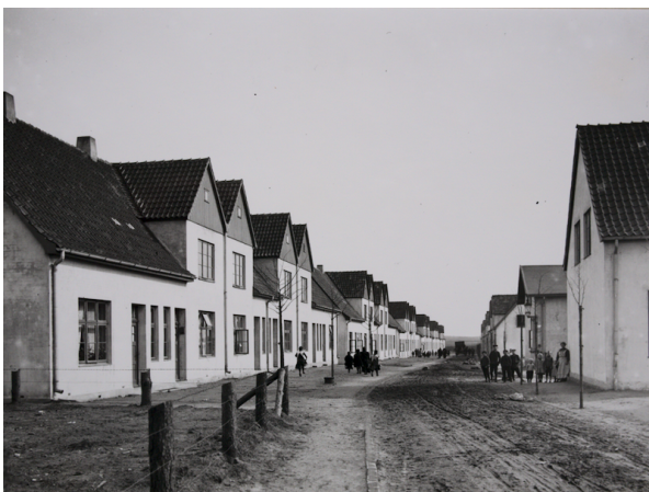
Abbildung 12: Arbeiterwohnhäuser in der Eisenstraße. (Quelle: Archiv Industriemuseum Geschichtswerkstatt Herrenwyk)
