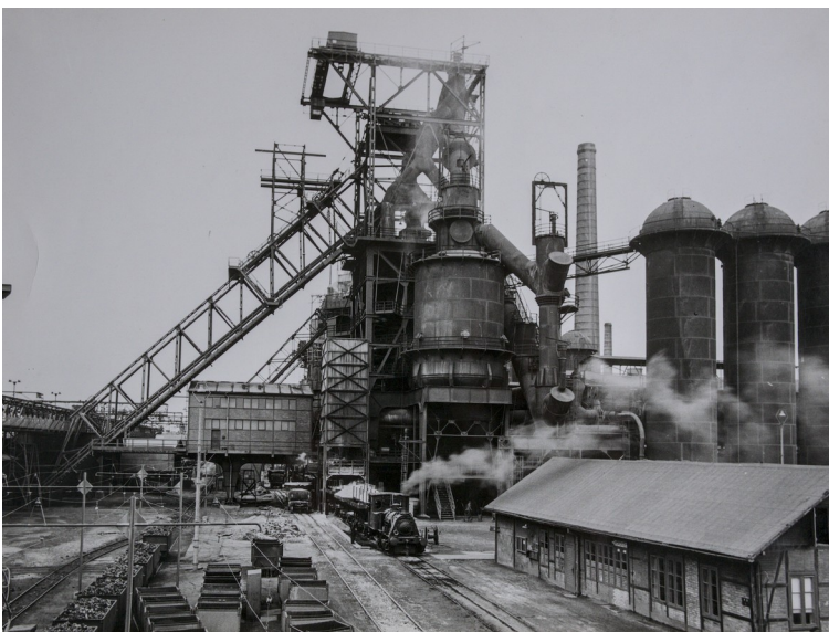
Abbildung 21: Hochofen und Winderhitzer (Quelle: Archiv Industriemuseum Geschichtswerkstatt Herrenwyk)
