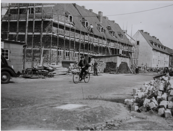
Abbildung 16: Neubau eines Altersheims, Gerstenfeld, Lübeck. (Quelle: Archiv Industriemuseum Geschichtswerkstatt Herrenwyk)
