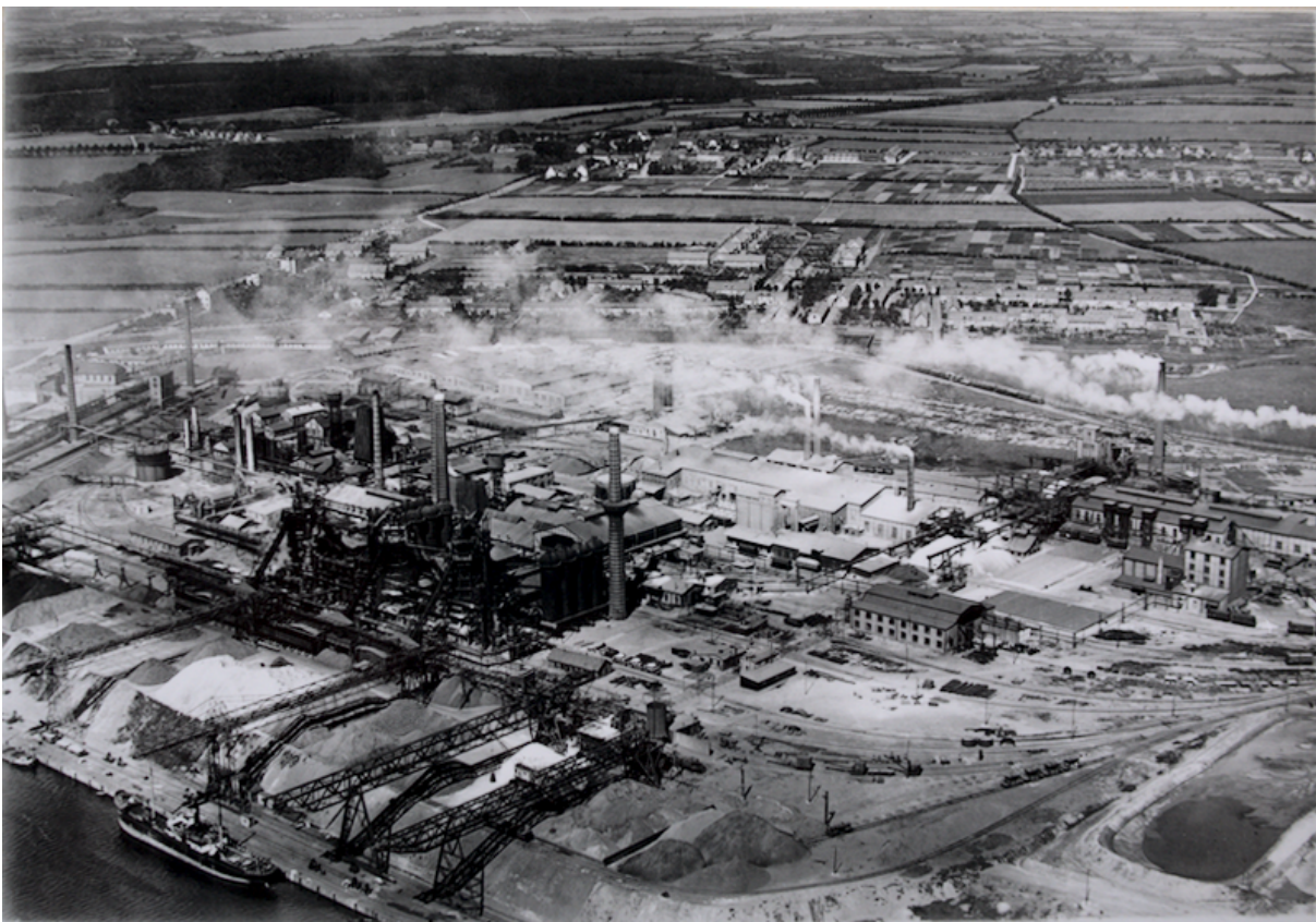
Abbildung 3: Luftaufnahme des Werks mit Arbeiterkolonie (Quelle: Archiv Industriemuseum Geschichtswerkstatt Herrenwyk)
