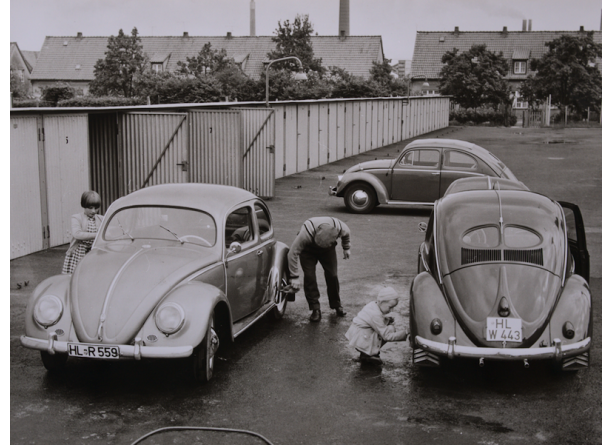
Abbildung 17: Neubau von Garagen. (Quelle: Archiv Industriemuseum Geschichtswerkstatt Herrenwyk)
